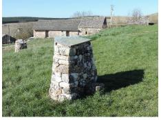
**Dimensionnement :** les ouvrages sont de tailles et de formes différentes, d'environ 1m à 1,20m de hauteur et environ 1m à 1,40m de largeur.
