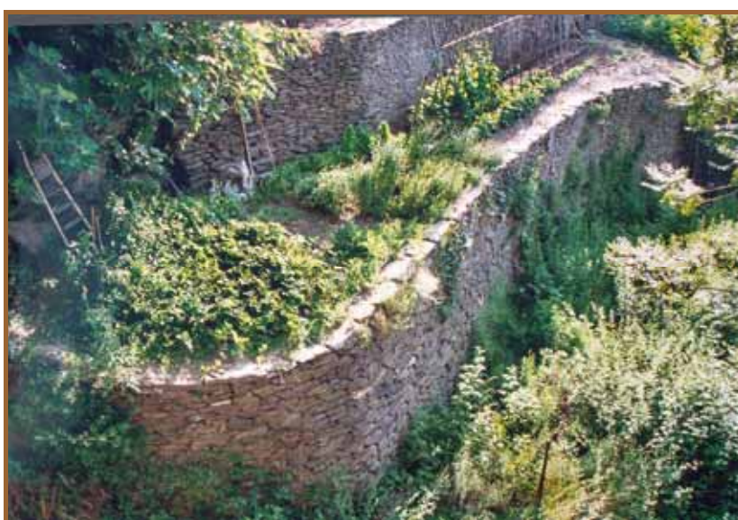
Photo 13 - Murs de terrasses réhabilités sur le site des Calquières à Saint-Germain-de-Calberte (Lozère). (cliché : Chambre de métiers et d'artisanat de la Lozère, ABPS)
