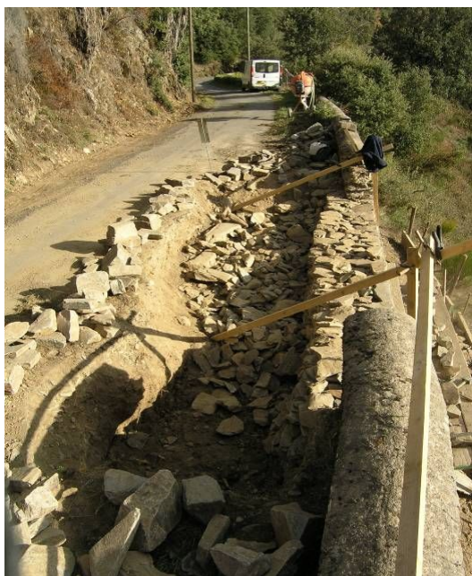
Mur de soutènement routier, schiste St Andéol de Clerguemort, 48, commande publique
