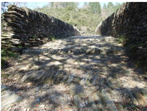
Restauration d'une calade, schiste, Le Pont de la Fage, 48 Commande publique
