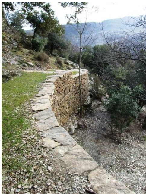
Mur de soutènement, schiste, à Vernet, 48 St Germain de Calberte, commande privée
