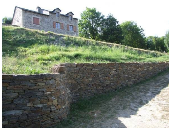
Mur de soutènement, schiste, Balazuègues, 48 Commande privée
