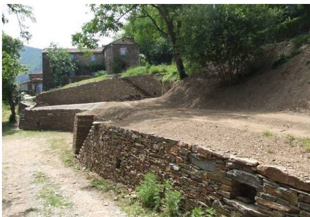
Mur de soutènement, schiste, Chamborigaud, 30 Commande privée
