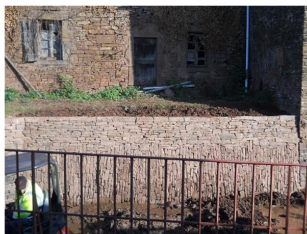
Mur terminé. Partie supérieure assisée.
