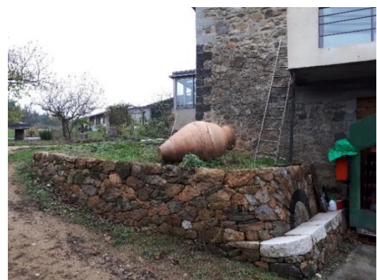
Vues du mur en opus incertum , du banc et de la terrasse avec étau posé sur le couronnement du mur
