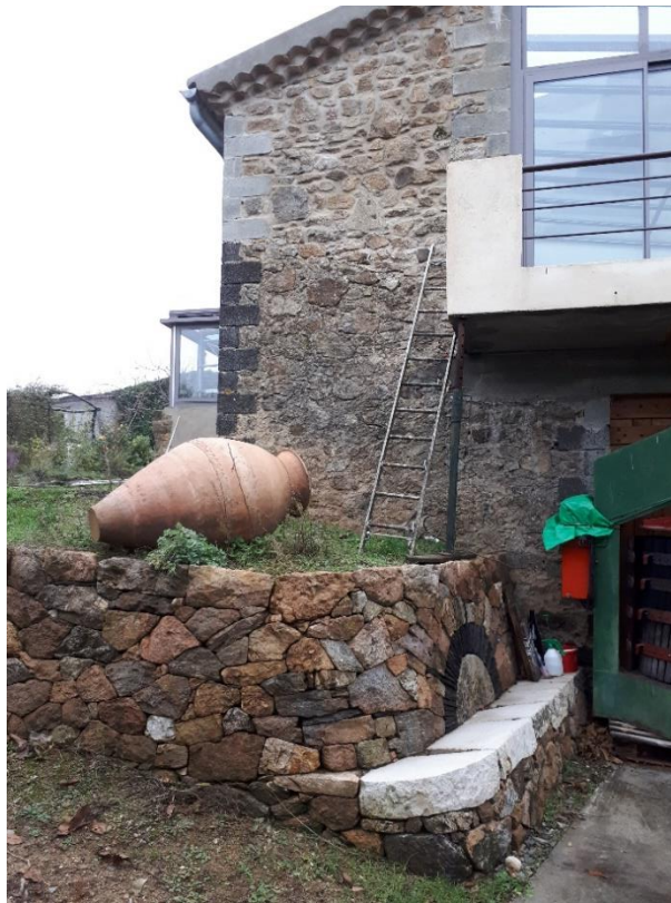
Vues du mur en opus incertum , du banc et de la terrasse avec étau posé sur le couronnement du mur
