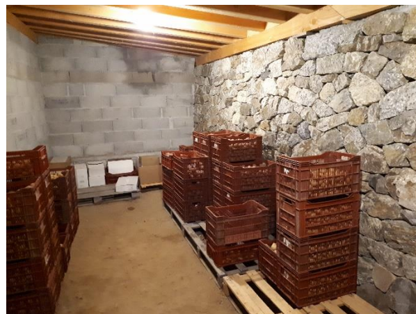
Côté atelier, mur adjacent en agglomérés de ciment
