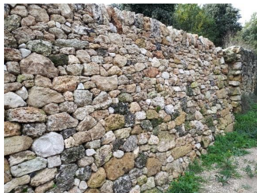
Mur de soutènement ; son parement opus incertum
