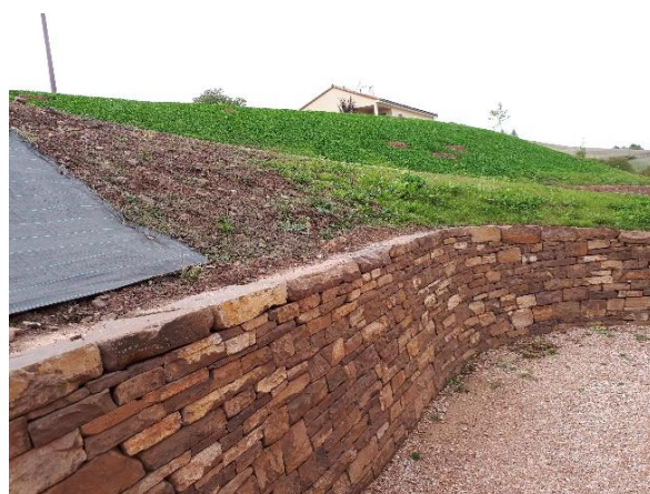
Parement du mur et enrochement dans le prolongement.
