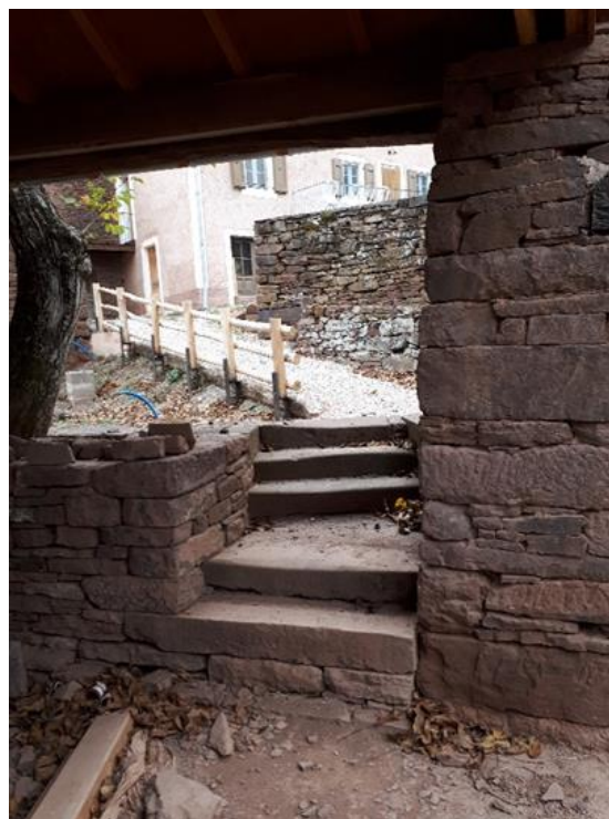
Le mur à double parement de la cuisine d'été et son escalier, grès rouge, opus assisé.
