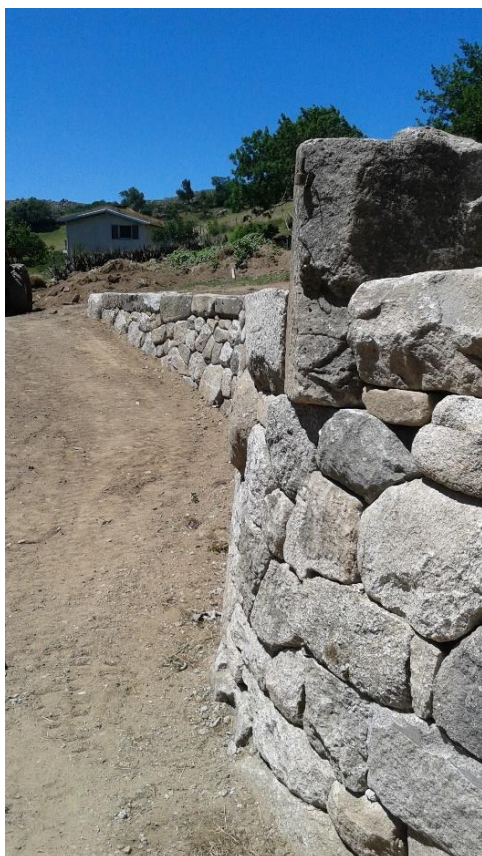
Le parement en opus incertum et ses courbes concave et convexe.
