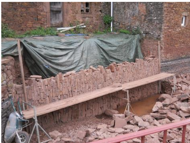
Deux tiers du mur construit en clavade
