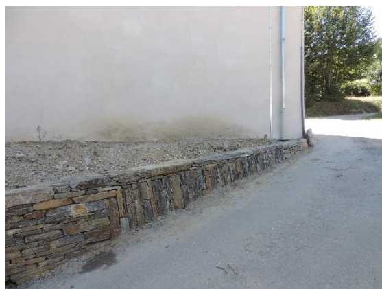
Vue d'ensemble de l'ouvrage, de la fondation clavée et de la chaîne d'angle
