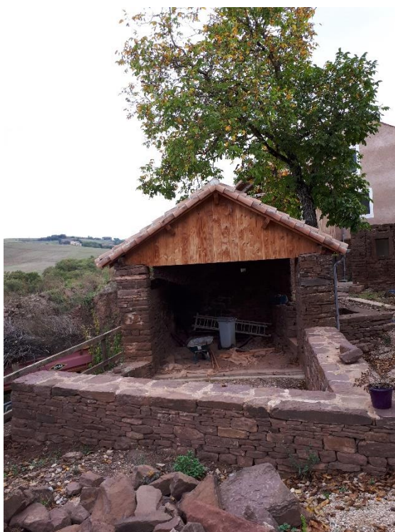
Le mur à double parement de la cuisine d'été et son escalier, grès rouge, opus assisé.
