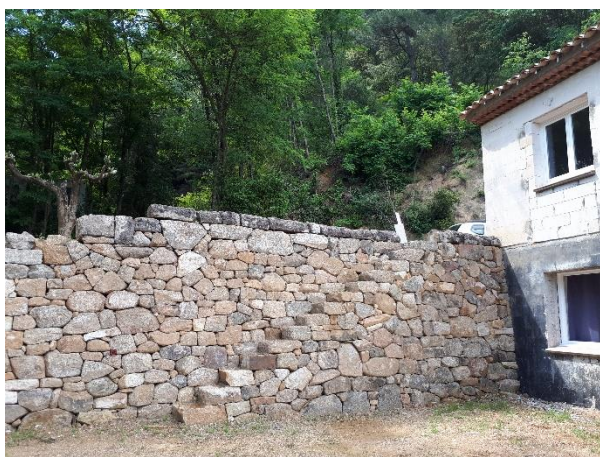
Mur de soutènement en opus incertum avec escalier intégré
