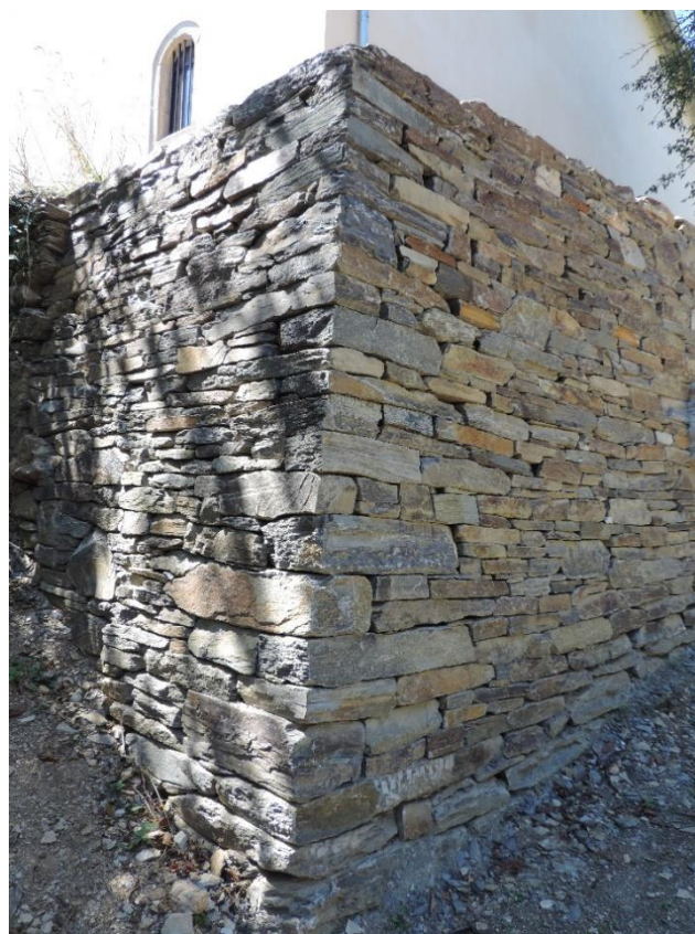
Vue d'ensemble de l'ouvrage, de la fondation clavée et de la chaîne d'angle
