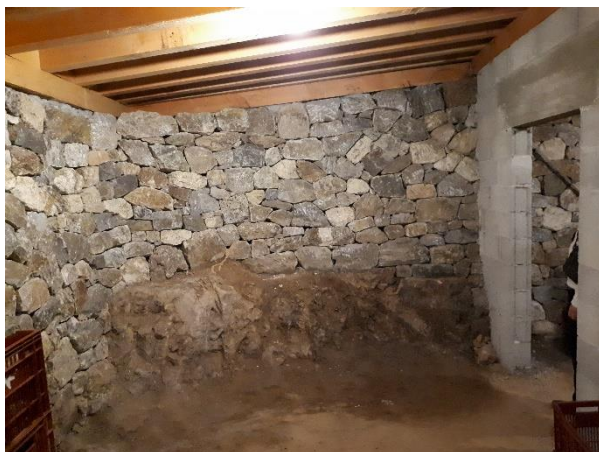
Intérieur de la cave, mur posé sur la roche mère
