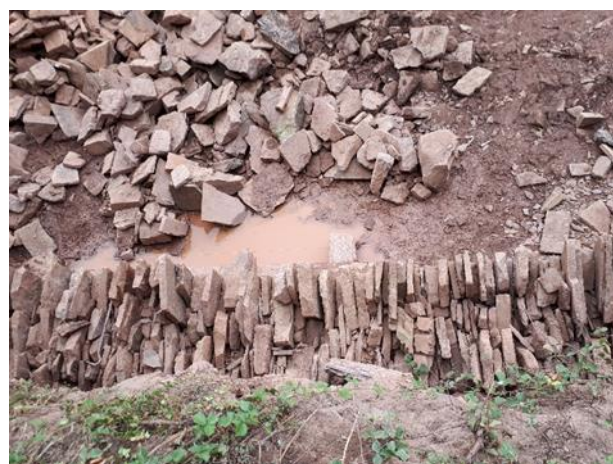
Fondations clavées vue de dessus
