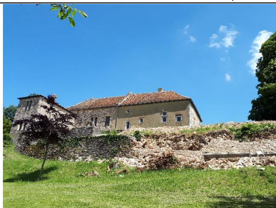
Vue de l'ensemble, chantier en cours
