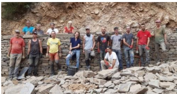
Chantier-école mur de soutènement (en schiste) Avec la mairie de Ventalon en Cévennes (48)
