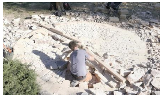
Chantier-école Calade (en calcaire) Avec la mairie de Collias (30)
