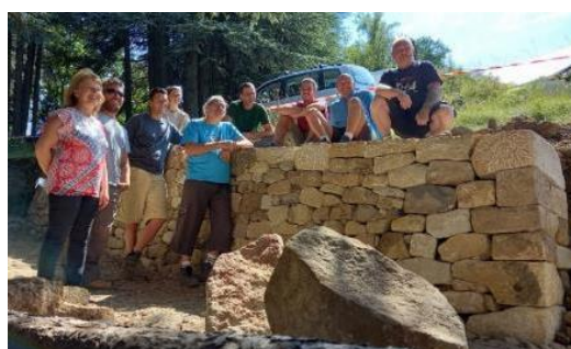
Chantier-école mur de soutènement (en calcaire et basalte) Avec la mairie de Privas (07)
