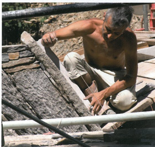
Les pierres de la voûte sont retaillées sur place avant d'être ajustées sur le cintre. Des cibles topométriques ont été installées pour mesurer les mouvements de la voûte lors du décoffrage. Le déplacement maximal enregistré à la clé a été de 1 mm.
