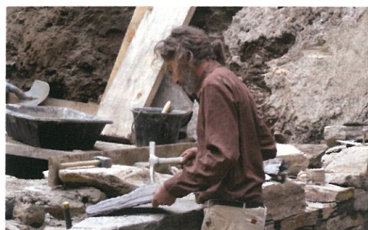
Les pierres de la voûte sont retaillées sur place avant d'être ajustées sur le cintre. Des cibles topométriques ont été installées pour mesurer les mouvements de la voûte lors du décoffrage. Le déplacement maximal enregistré à la clé a été de 1 mm.
