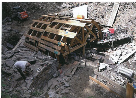
Après le terrassement, des radiers ont été maçonnés afin d'accueillir les culées du pont. Le coffrage de la voûte est composé de sept "vaux" (éléments semi-circulaires), en mélèze, reliés par des "couchis" (planches transversales).
