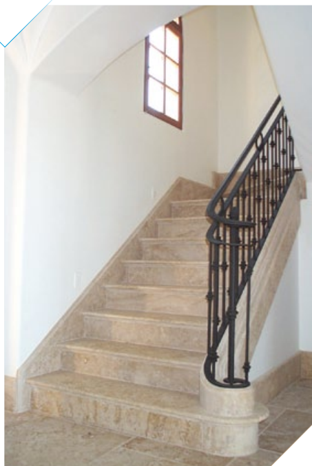
Figure 10 - Revêtement de sol scellé
