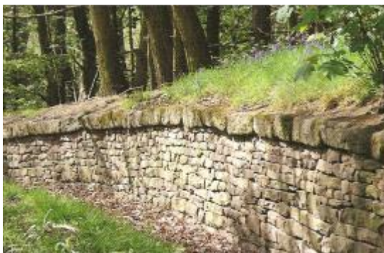
Figure 5: Couronnement des murs en pierre sèche: en grosses pierres plates à gauche, en clavade à droite
