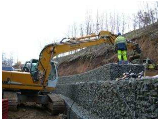
Figure 18: Tractopelle remplissant les gabions
