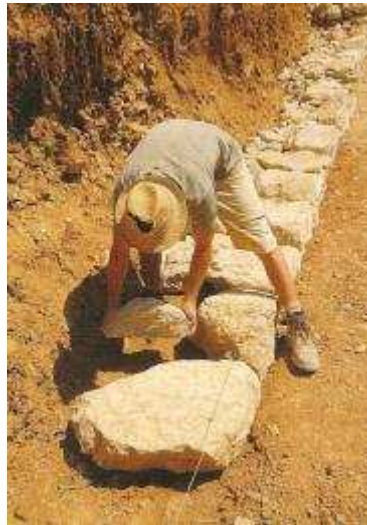
Figure 2: Pose des pierres de socle
