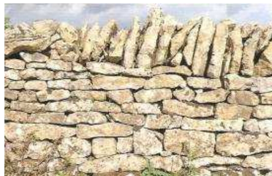
Figure 5: Couronnement des murs en pierre sèche: en grosses pierres plates à gauche, en clavade à droite
