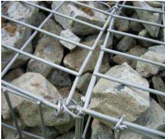
Figure 16: Agrafes entre les différents panneaux
