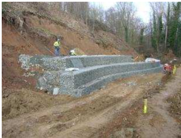
Figure 12: Chantier en cours de réalisation utilisant la technique du gabion
