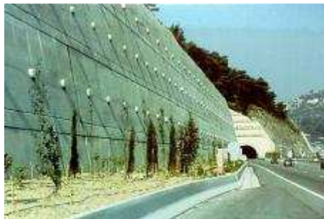
Figure 24: Exemple de mur cloué
