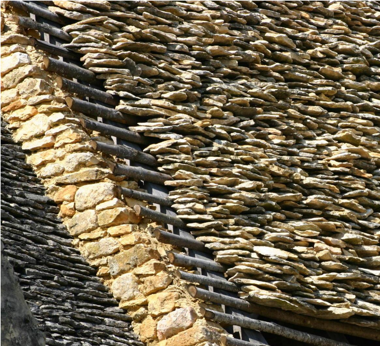
Couverture en lauzes calcaires (Udap Dordogne)
