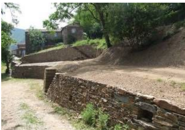
Mur de soutènement, schiste, Chamborigaud (30) Commande privée
