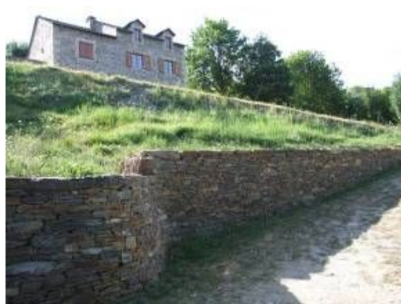
Mur de soutènement, schiste, Balazuègues (48) Commande privée
