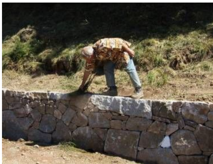
Mur de soutènement et artisan ABPS, granit, Le Pont de Montvert (48) Commande publique
