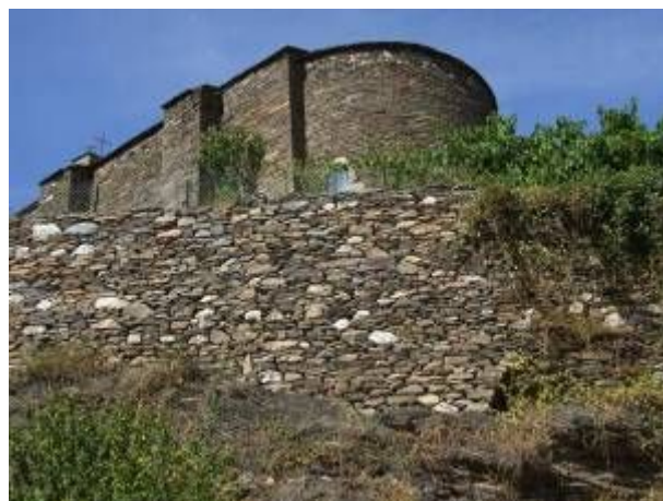
Restauration d'un mur de soutènement, schiste Eglise de Ste Croix Vallée française, 48 Commande publique
