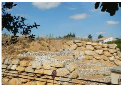
*Par exemple à Thézan-les-Béziers, le propriétaire lotisseur a choisi de combiner des enrochements pour stabiliser deux versants au dessus du lotissement. Des murets en pierre sèche (ici des galets) vont limiter le ravinement et permettre d'étager la terre en mini-terrasses.*
