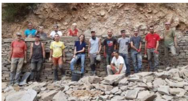
Chantier-école mur de soutènement (en schiste) Avec la mairie de Ventalon en Cévennes (48)
