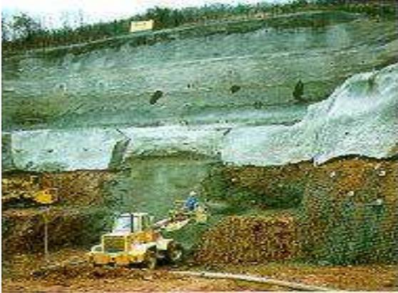
*Figure I.12 : Préparation d'une nouvelle étape de projection*
