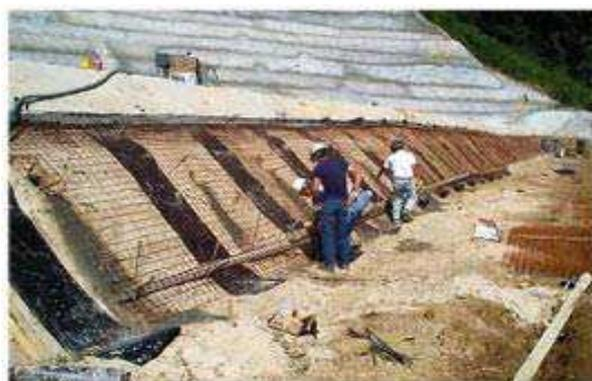
Figure I.10 : Mise en place d'un treillis soudé
