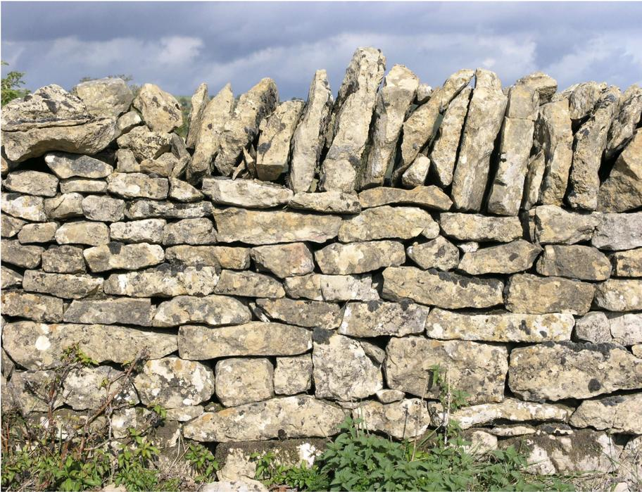
Figure I.2 : Disposition d'un couronnement en chant
