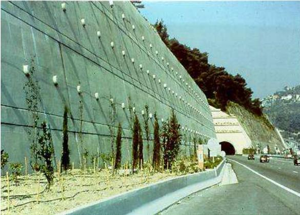
Figure I.9 : Mur cloué le long d'un axe routier
