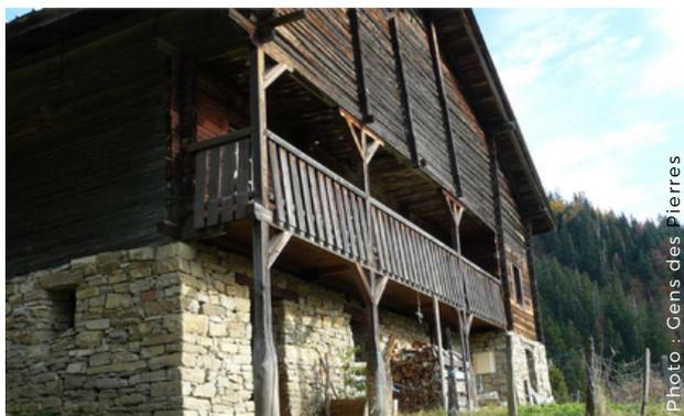
prémunir : des avancées de toit plus prononcées pour protéger les façades mais aussi par l'utilisation de soubassements et des fondations en moellons de pierre.
